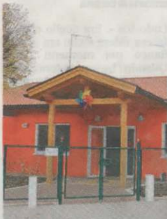
L'asilo nido di Travacò
